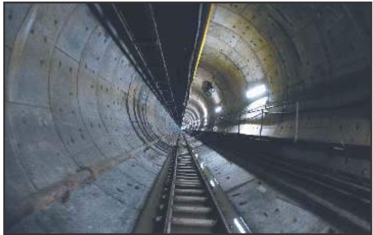
Drenaje profundo Zumpango, Estado de México.
