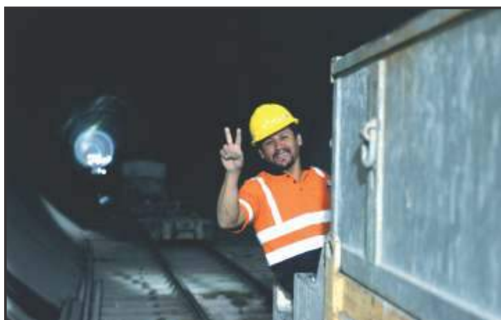
Bajo la tierra Drenaje profundo, Zumpango, Estado de México.
